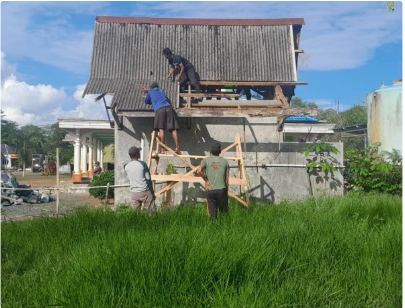
MCK Masjid Al Mujahidin Desa Telaga Langsat Dibongkar Satgas TMMMD Ke 117
